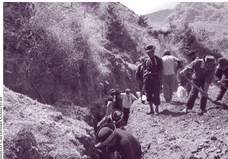
Faena de limpieza de la acequia.
